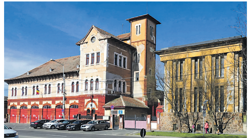
Die Josefstädter Feuerwache, von László Székely entworfen, ist wie viele andere Gebäude dringend renovierungsbedürftig.
