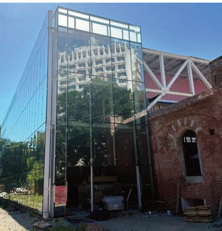
Seriöse Umbaumassnahmen an der alten Sport- halle, mit Integration der alten Architektur
